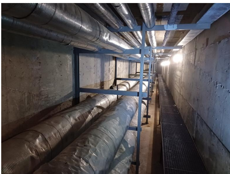
Potrubní rozvody chladicí vody v kolektoru
